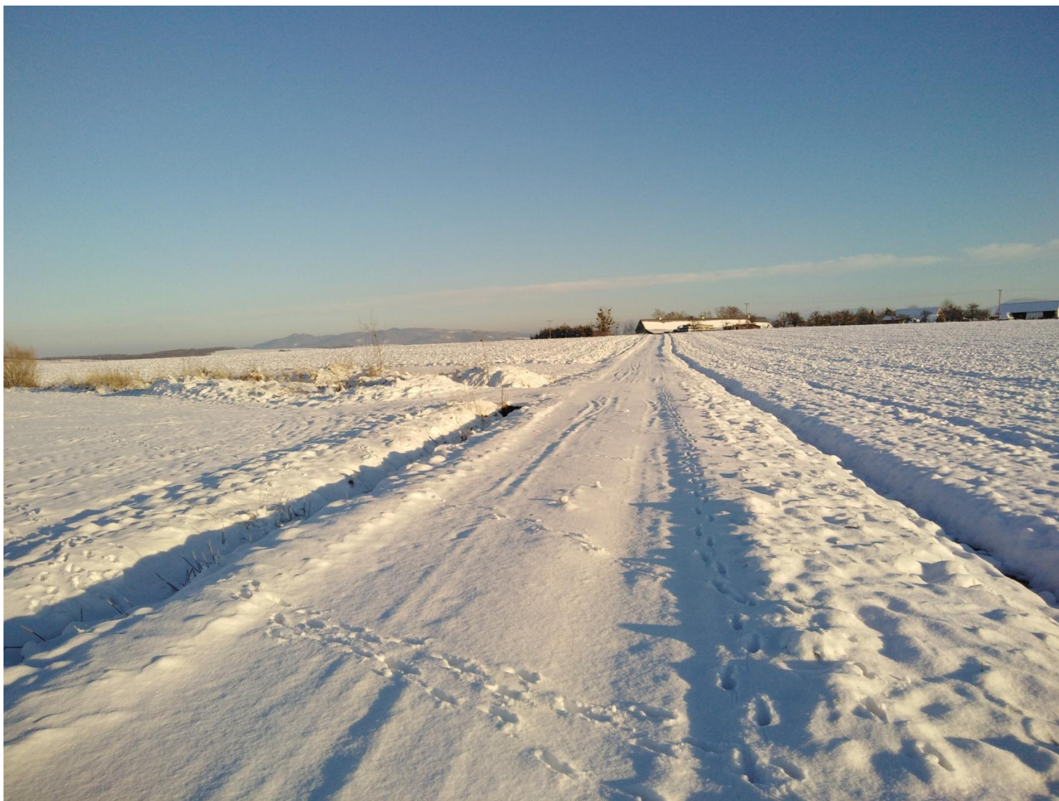
Obrázek 5 Realizace by zamezila erozi cesty, která stále probíhá
