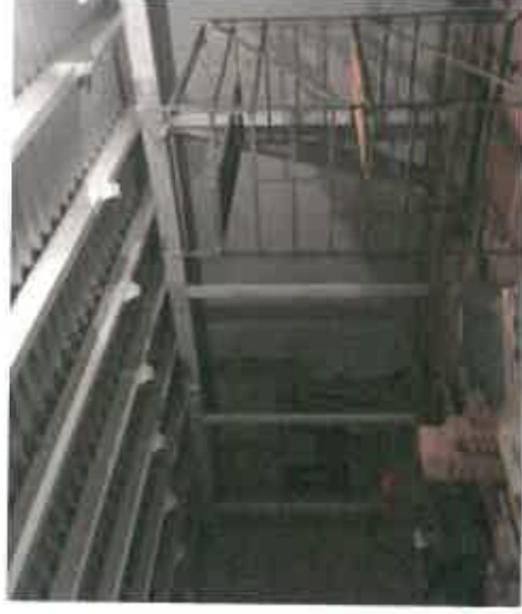
Přízemí Budování stropu nosné ocelové sloupy, Přeclady a na nich trapézové plechy
