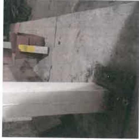
Sklep Železobetonové základy s nosnými ocelovými sloupy
