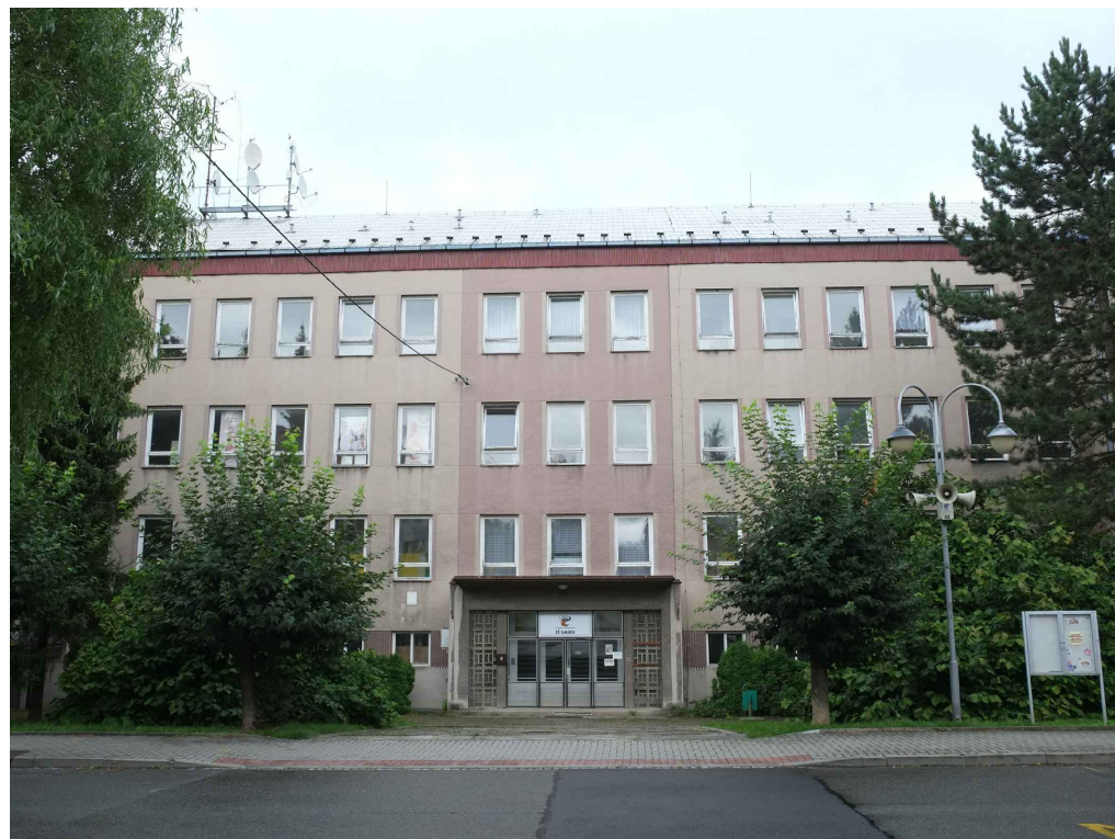
Pohled na hlavní fasádu se vstupem
