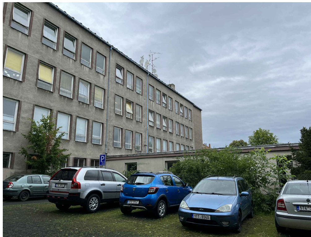
Pohled na jinovýchodní fasádu a spojovací krček tělocvičny
