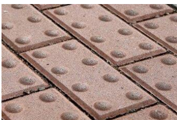
Reliéfní dlažba (varovné a signální pásy)
