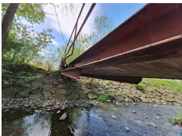
Nosná ocelová konstrukce "I" nosník v = 170 mm
