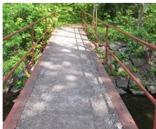
Celkový pohled, šířka mostovky 170 cm
