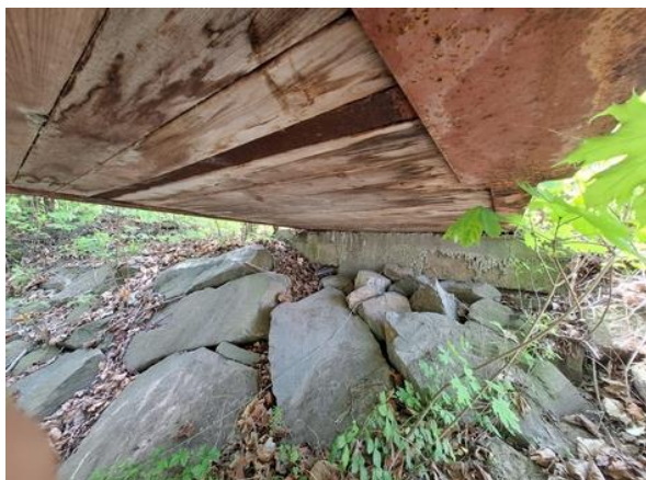
Úložný betonový práh nosné konstrukce – levý
