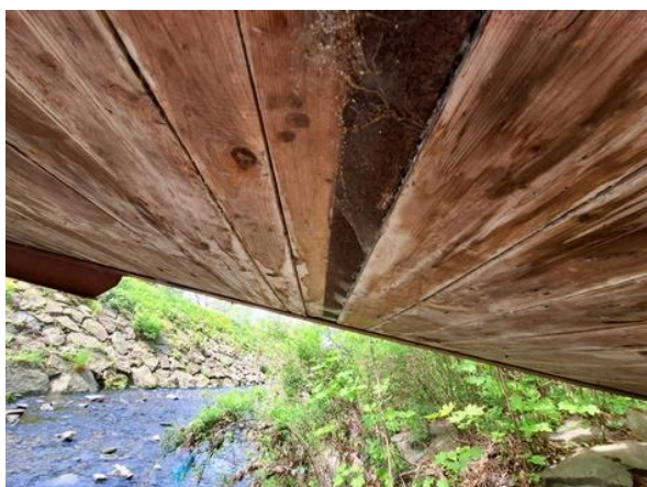
Detail – podhled mostovky – ztracené dřevěné bednění
